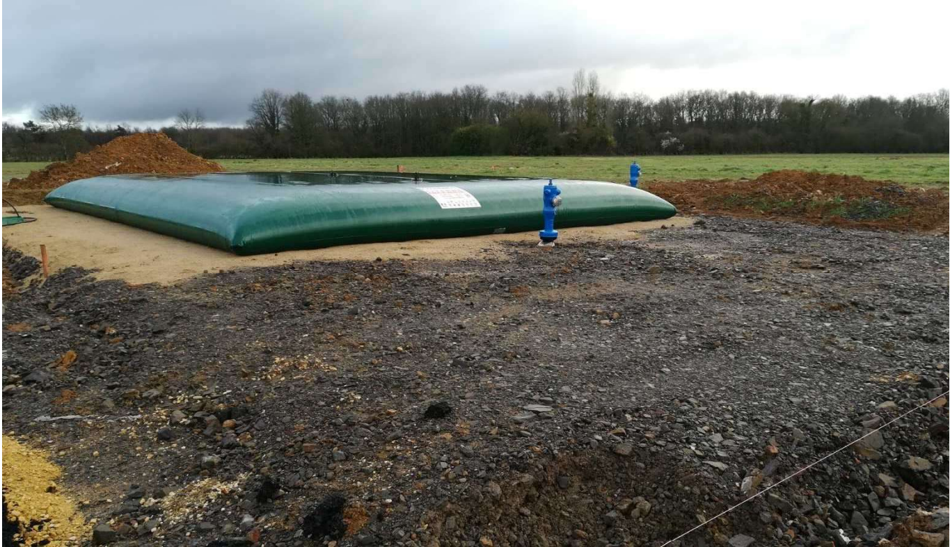
Figure 2 : Réserve incendie implantée – travaux en cours dans le cadre de l'aménagement de la ZAE
